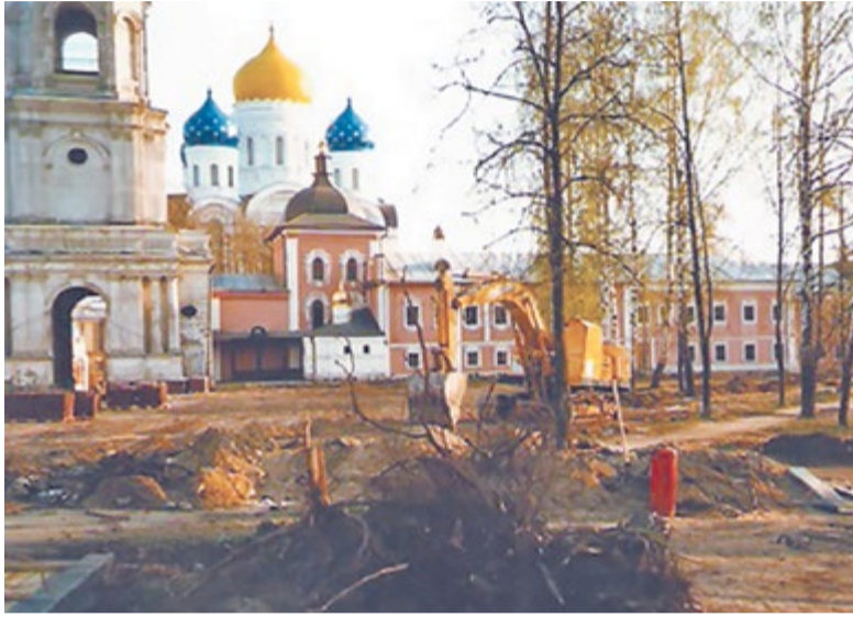
Начало восстановительных работ
