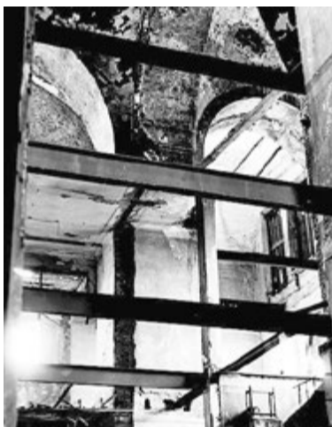
Металлические балки перекрытий в основном объеме Преображенского собора. Фото 1980-х годов
