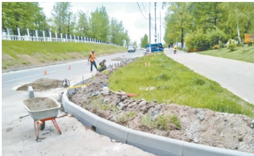
Замена бордюрного камня на улице Ленина
