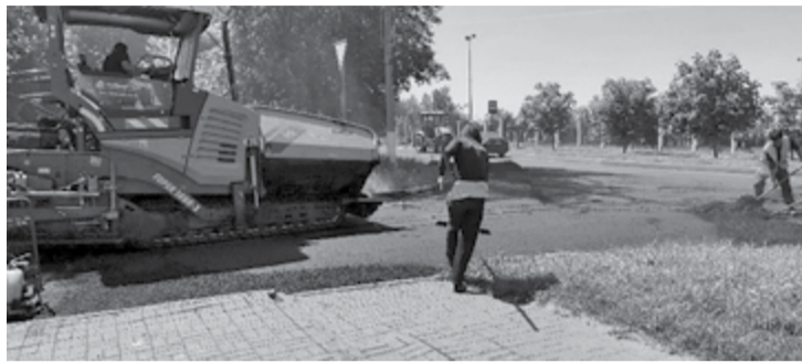
Укладка асфальта на улице Ленина
