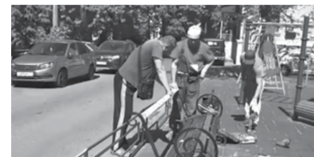
Ремонт скамейки на Ленина, 12
