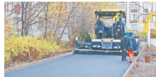
Укладка асфальта у дома 18 по улице Угрешской
