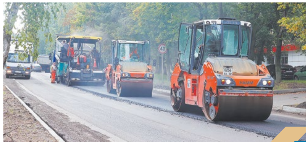
Укладка асфальта на улице Дзержинской
