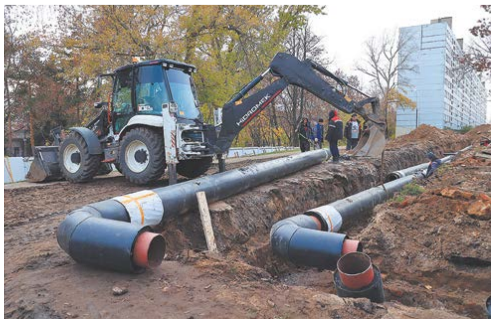
Замена теплосетей у дома 10 по улице Спортивной
