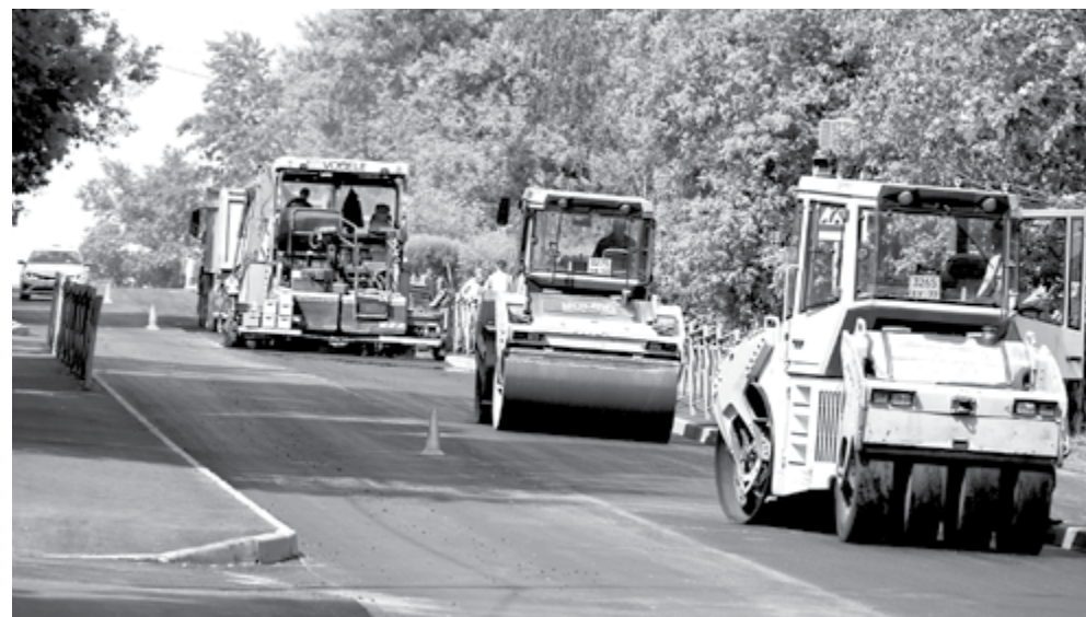
Укладка асфальта на улице Лермонтова
